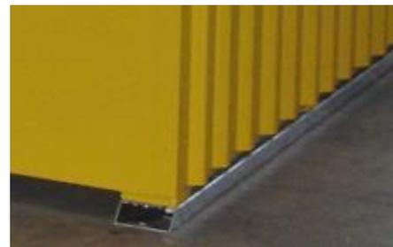
En cas de nécessité (Rare) des cales peuvent être fixée pour assurer le nivellement en cas de forte pente.
